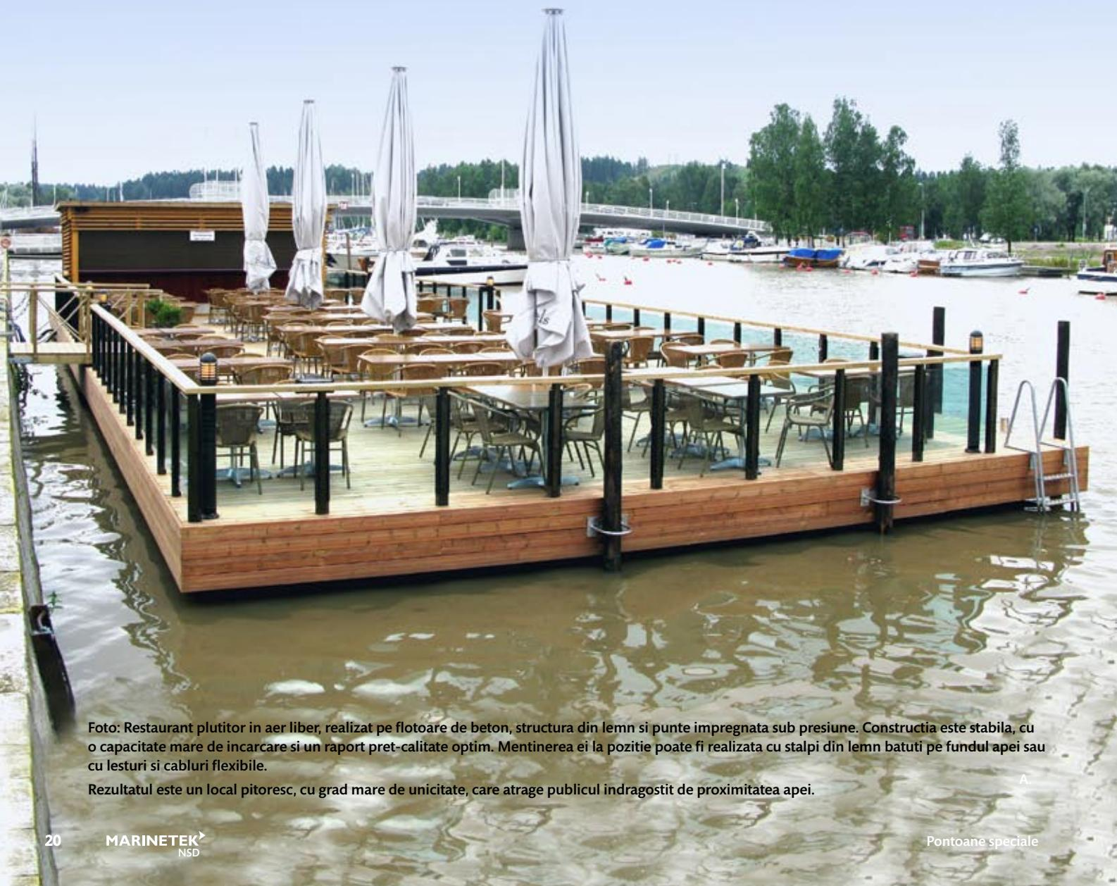
Foto: Restaurant plutitor in aer liber, realizat pe flocatoare de beton, structura din lemn si punte impregnata sub presiune. Constructia este stabila, cu o capacitate mare de incarcare si un raport pret-calitate optim. Mentinerea ei la pozitie poate fi realizata cu stalpi din lemn batuti pe fundul apei sau cu lesturi si cabluri flexibile.
